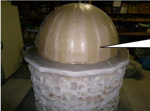
平行して製作した半円形のダンボールの型枠です。
