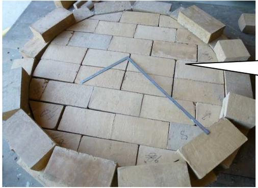
円筒部は「炭焼き」を前提としていますので底の厚みは「焼き床+レンガ2段」の3層構造です。
