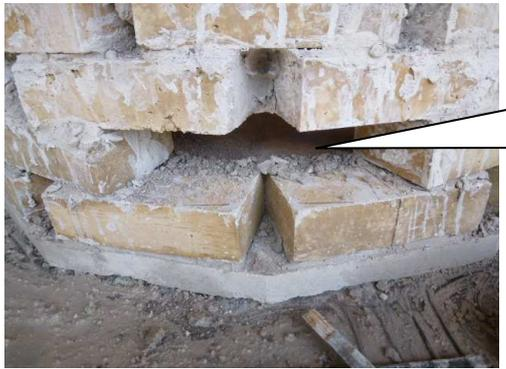
「炭焼き」の排煙部の構造。ここに煙突を設置しますが、「炭焼き」毎に煙突を外し塞ぐ構造になります。
