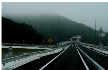
新装になった京都縦貫道
