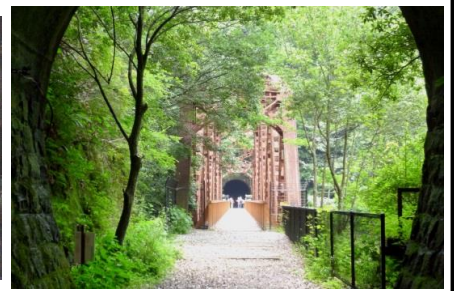
第2武庫川橋梁
