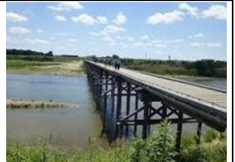
流れ橋(上津屋橋)
