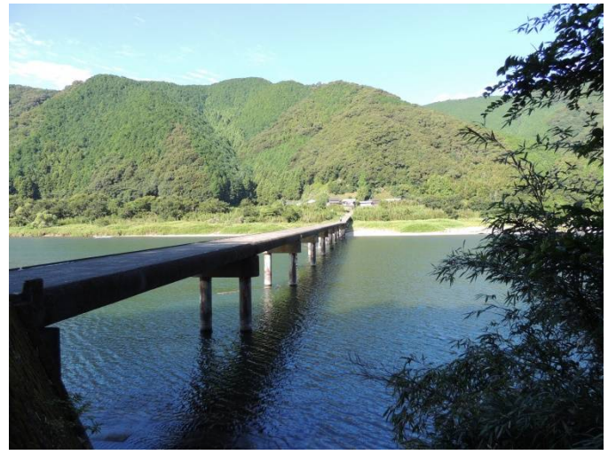
四万十川 沈下橋
