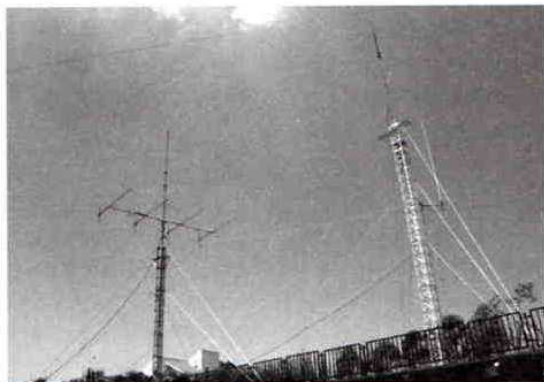
BU2AQ 呉さんのシャックと144MHzの設備(標高500m) 使用リグはIC-275とIC-7000。アンテナは15m高タワーに15エレ×4バラ、10Dの同軸ケーブルを使用している。なお、出力は50Wだった
