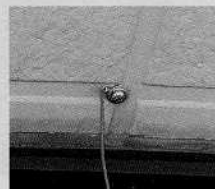
写真A 壁面に打ったアース用ボルト
